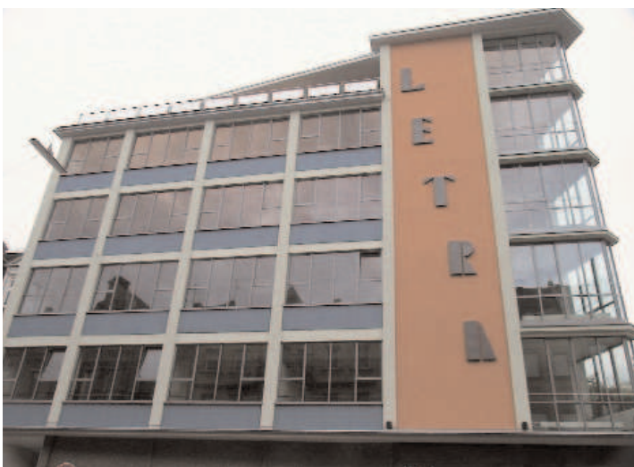
2 Im Zuge der Dämmarbeiten am Letra-Haus wurden von der Malerfirma die Buchstaben abgenommen, gereinigt, Risse gelötet und schließlich an gleicher Stelle wieder befestigt.
