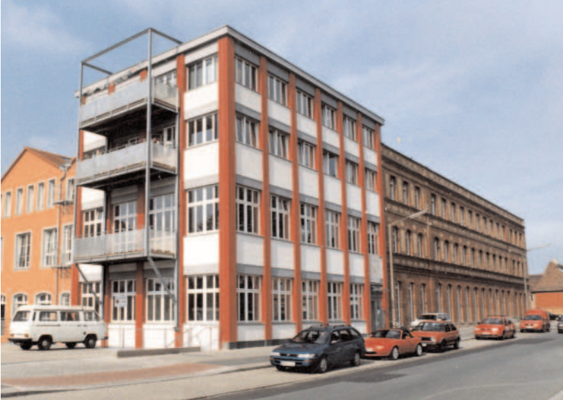
1 Die ehemalige Tabakfabrik an der Pegnitz in Nürnberg. Der vordere Komplex erhielt ein Wärmedämm-Verbundsystem.
